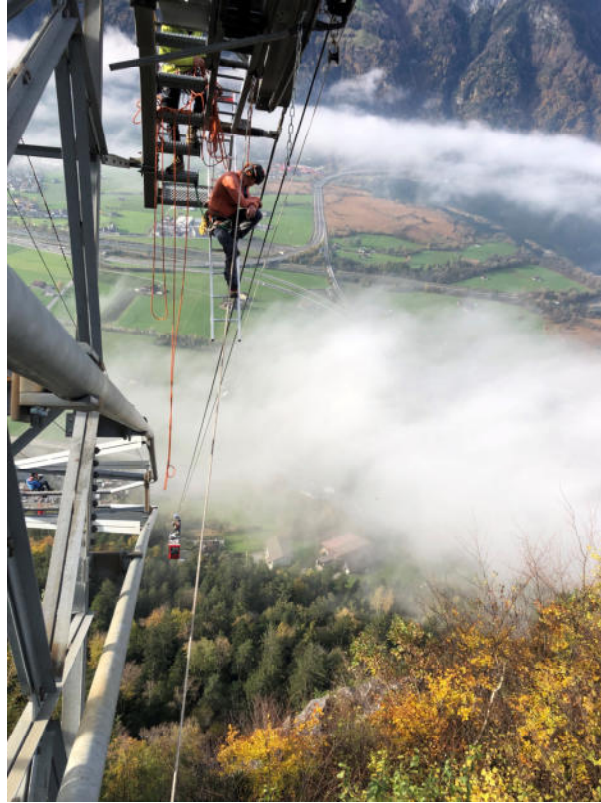
Revision Bahnanlage November 2022
