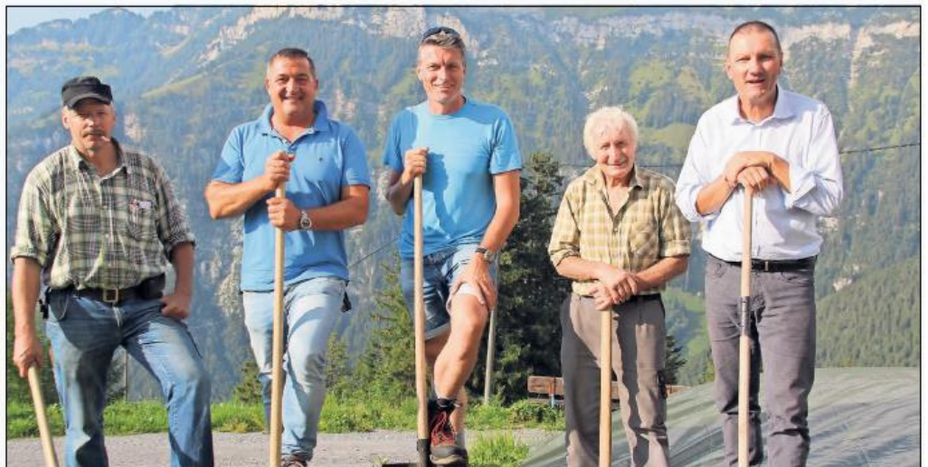
Am Spatenstich beteiligten sich: (von links) Hermann Herger (Gotthard Holzbau GmbH), Remo Bulgheroni (Präsident der Skiliftgenossenschaft), Erich Aeschlimann (Kassier), Hans Planzer und Jules Christen (Aktuar). FOTO: PAUL GWERDER
